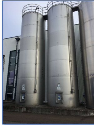
Distribution centralisée matière première avec contrôle humidité.
