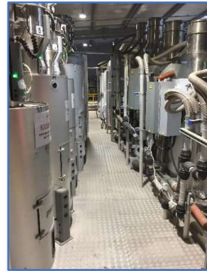
Distribution centralisée matière première avec contrôle humidité.
